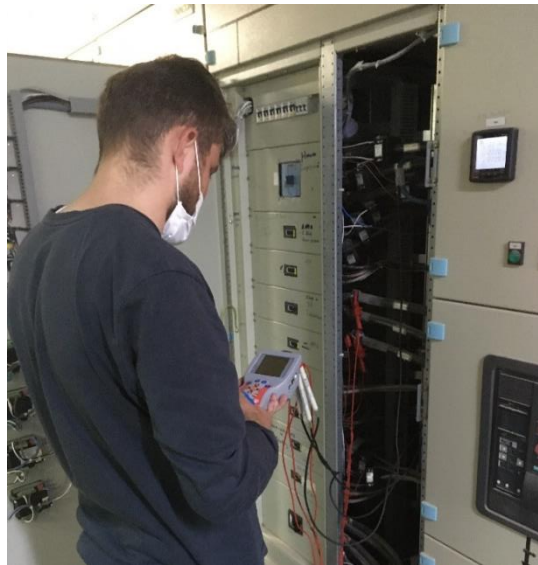
Şekil 4.20. Kompresör Enerji Tüketimi Ölçümü
