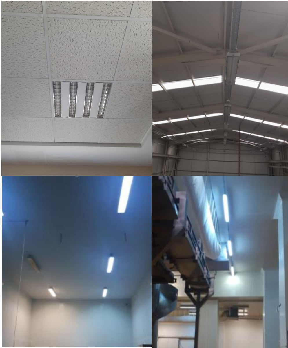
Şekil 4.24. Tesiste Bulunan Bazı Verimsiz Lambalar
