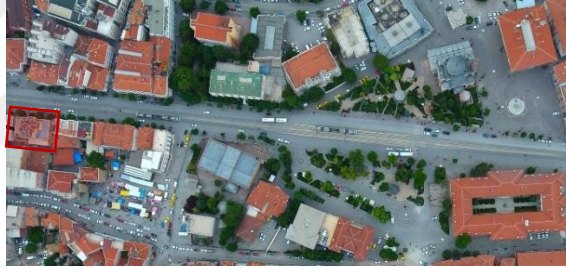
Şekil 3.62. Tekel Binası Kaynak: Ali Çağlar şahsi arşivinden
