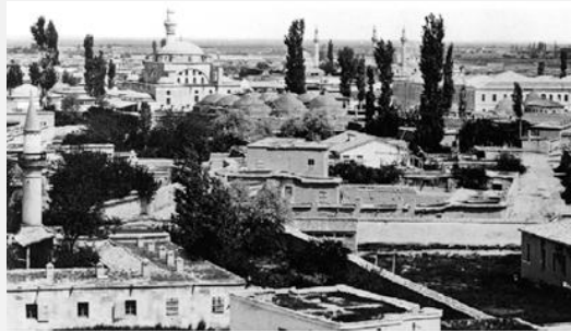
İbrahim Bey Külliyesi (Uz, 2009).
