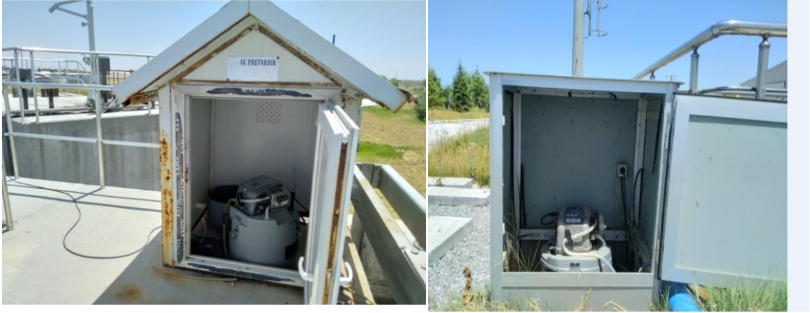
Şekil 3.2. Tesis girişi ve ön çökeltilim havuzu çıkış noktası numune alma cihazları
