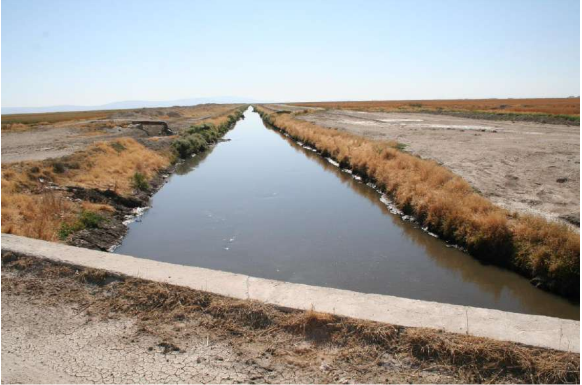
Şekil 3.20. Apa Tahliye Kanalı - Pompa No:1 Girişi
