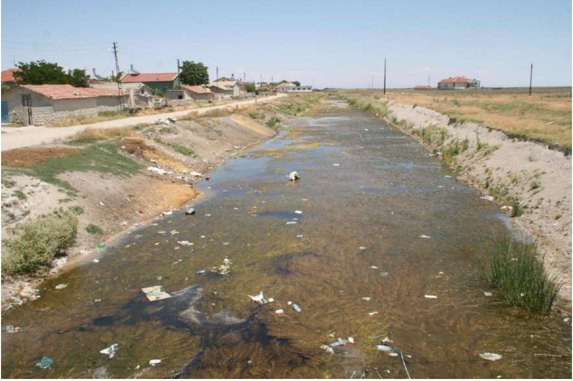
Şekil 3.21. Apa Tahliye Kanalı – Gölyazı Köprüsü
