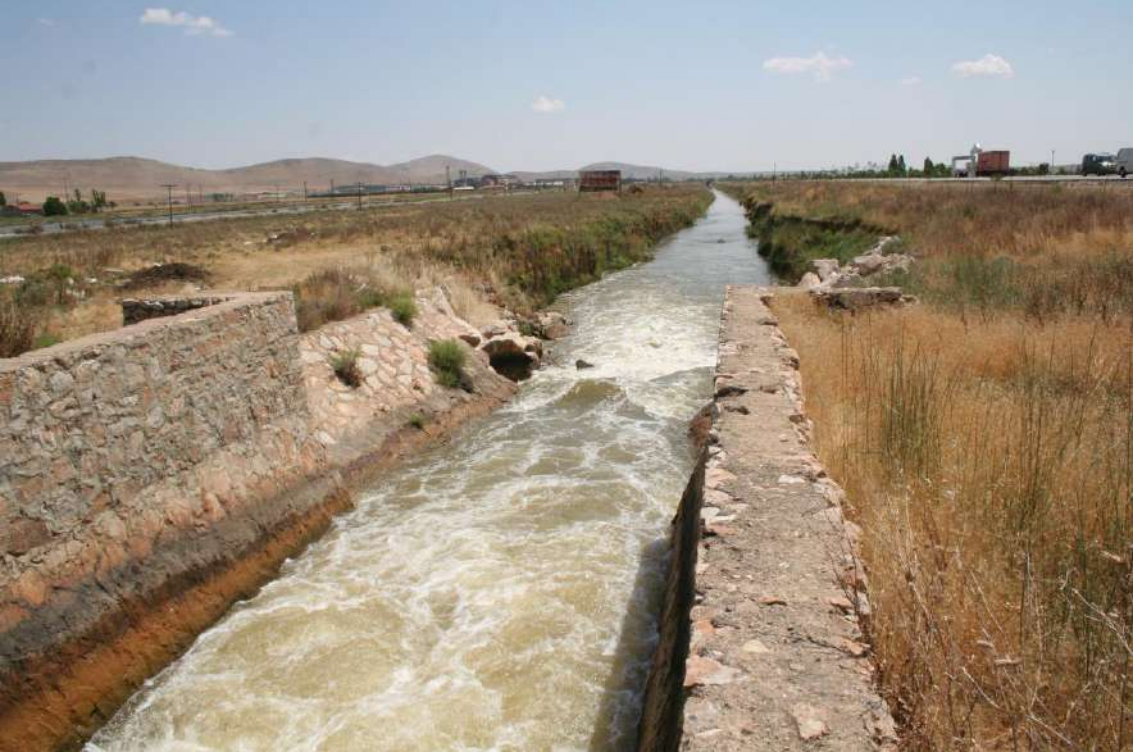
Şekil 3.22. Atlantı Sulama Kanalı – Orhaniye Köprüsü
