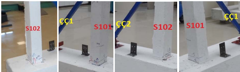
Şekil 4.45. Deney numunesi 3'ün, göçme konumunda kolon-temel birleşiminde oluşan hasarlar
