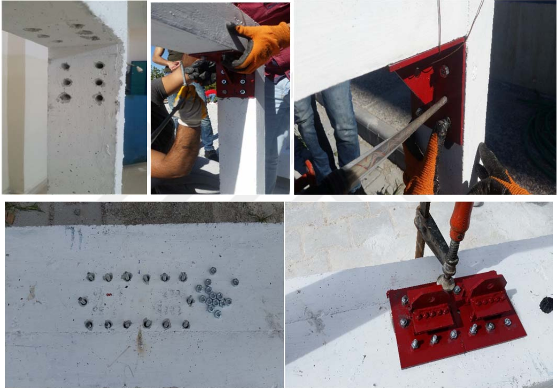
Şekil 3.6. Ankraj deliklerinin hazırlanması ve ankraj bulonlarının ekilmesi
