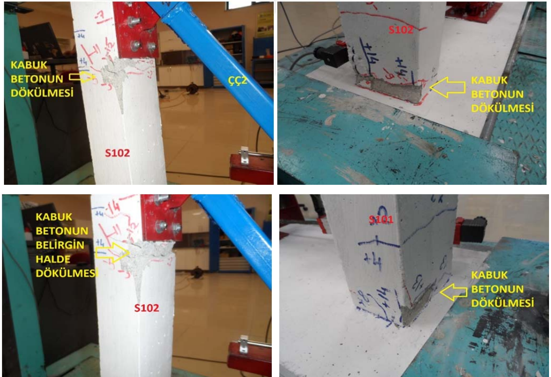
Şekil 4.56. Deney numunesi 4'te +21 ve -21 çevrimlerinde kolonlarda oluşan hasarlar
