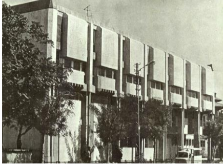
Resim 3.15. Merkez Bankası ön cephesi (Mimarlık s.76)
