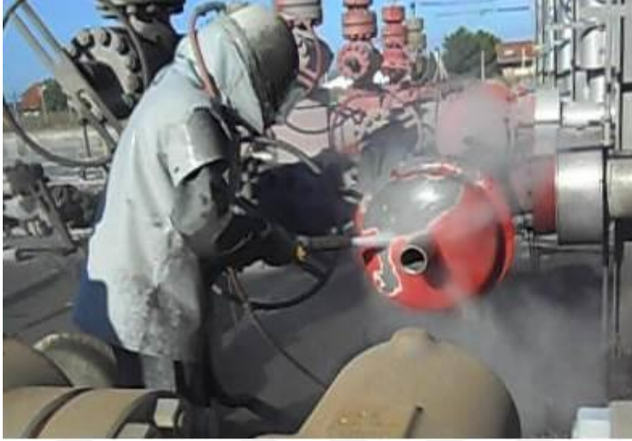
Şekil 3.3. Boya öncesi yüzey temizliği için yapılan kumlama örneği
