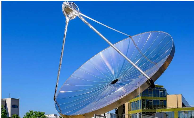
Şekil 1.7. Parabolik çanak tipi yoğunlaştırıcı sistem (Özcan, 2021)
