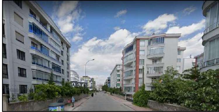
Şekil 4.44: Fetih Mahallesi sokak manzarası (Googlemaps,2022)
