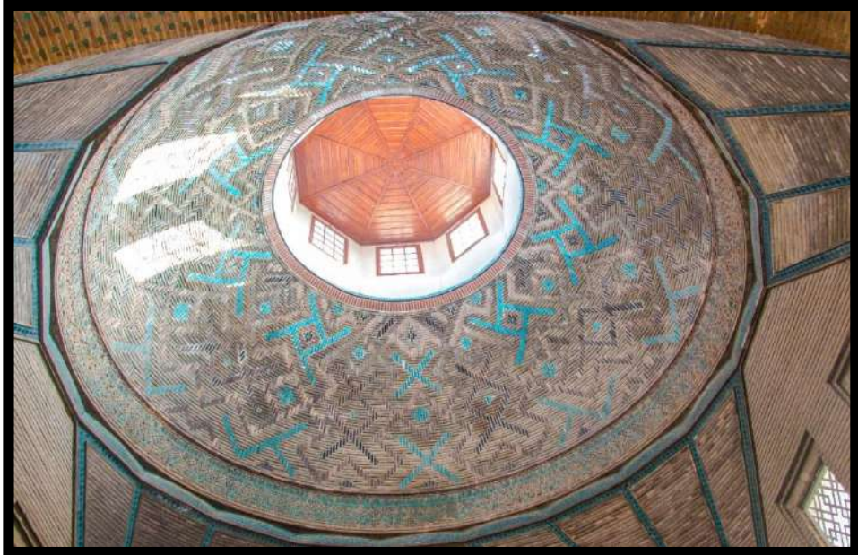
Şekil 5.7. Medresenin Kubbe örtüsü ve aydınlık feneri
