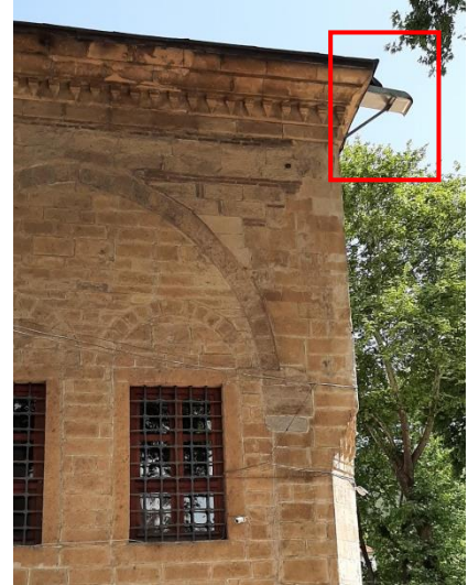
Resim 5.13. Yetersiz gelen akaçlama için sonradan eklenen metal çörtlen
