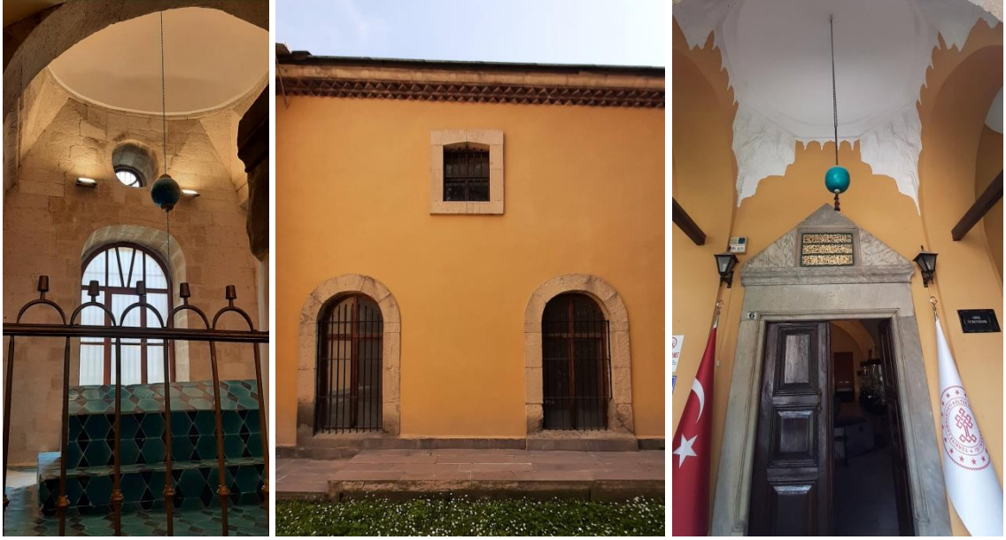
Resim 5.31. Solda türbe eyvanının yuvarlak kanatsız ve kemerli kanatlı ahşap pencereleri, ortada kemerli çift kanatlı ve düz atkılı kanatsız pencereler, sağda ise mermer üçgen alınlıklı giriş kapısı
