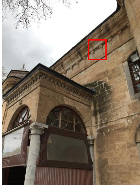
Resim 5.11. Solda doğu cephe giriş saçağı ve ana yapı kornişleri ve furuşları (işaretli elemanlar furuş), sağda son cemaat yeri camekânlı giriş saçak kornişleri ve üçgen alınlık
