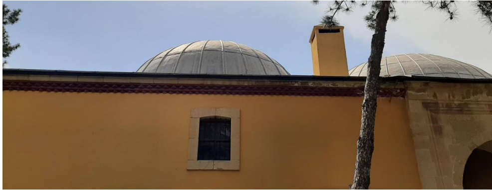
Resim 5.32. Güney tabhane mekânının bacası ve baca şapkası
