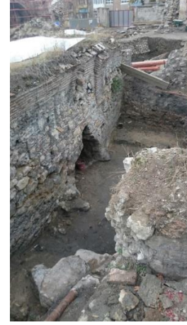
Resim 5.40. Solda külhanın üstten görünüşü 8 , üstte su deposunun görünüşü
