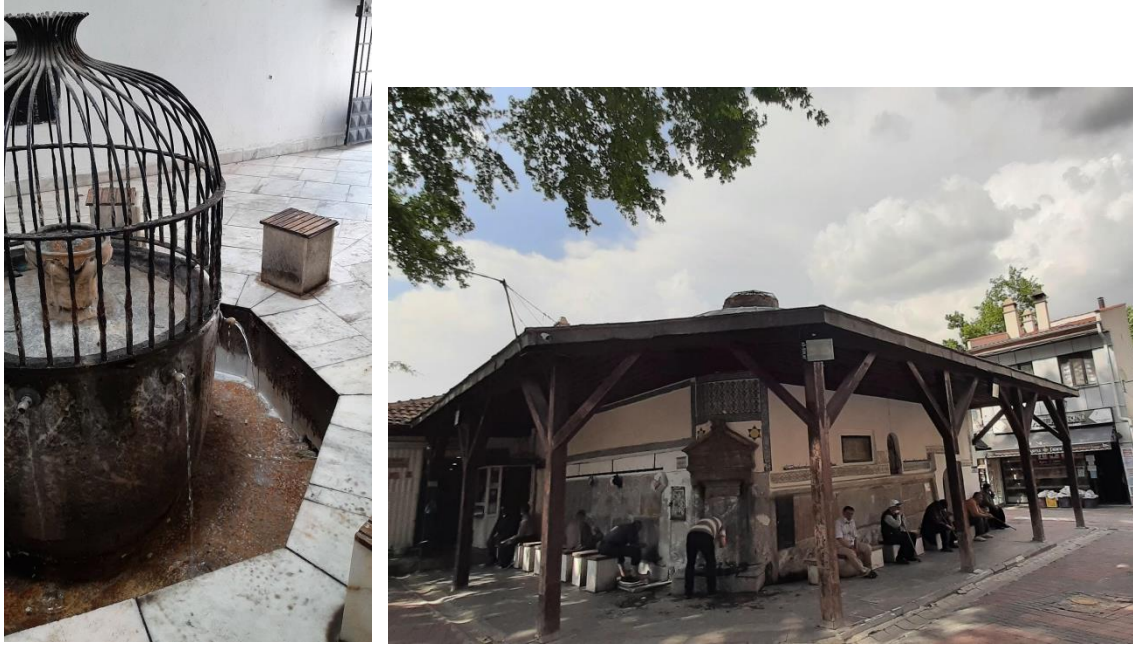
Resim 5.34. Solda sakahanenin şadırvanında temiz suyun aktığı fıskiye ve lüleleler, atık su tahliye gideri ve sağda sakahanenin cephesindeki mermer çeşmeler ve köşe çeşmesi
