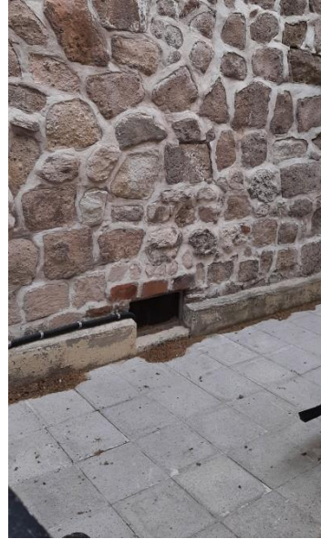
Resim 5.24. Batı kanadının yıkılması ile doğrudan dışarı açılan pencere boşluğu ve sergi mekânındaki havalandırma menfezi
