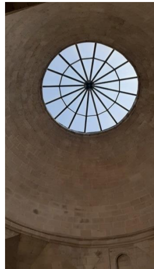
Resim 6.3. Vacidiye Medresesi'nin camekânla kapatılan kubbe açıklığı
