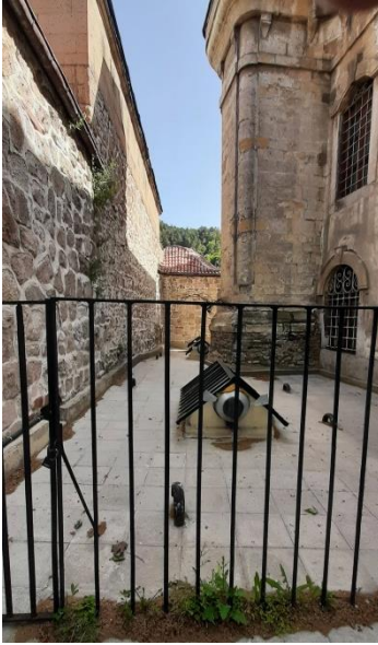
Resim 5.23. Batı kanadının yıkılması ile idare ve depoların aydınlatılması, havalandırılması
