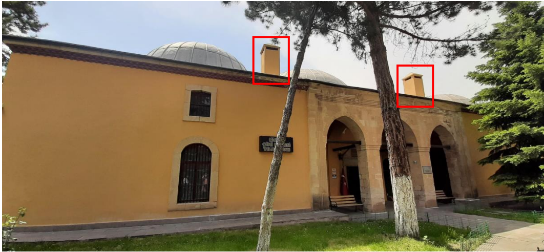
Resim 5.27. Tabhane mekânlarındaki ocakların simetrik baca çıkışları
