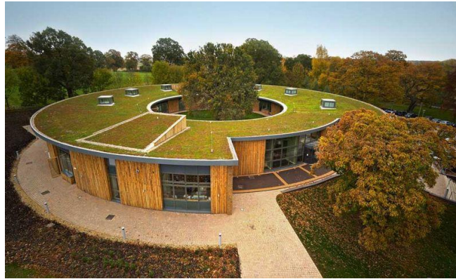
Şekil 3.16. Uygulanmış bir yeşil çatı örneği (URL-45)
