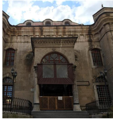
Resim 5.2. Ulu Cami doğu girişi, giriş saçığı ve branda ile kapatılması
