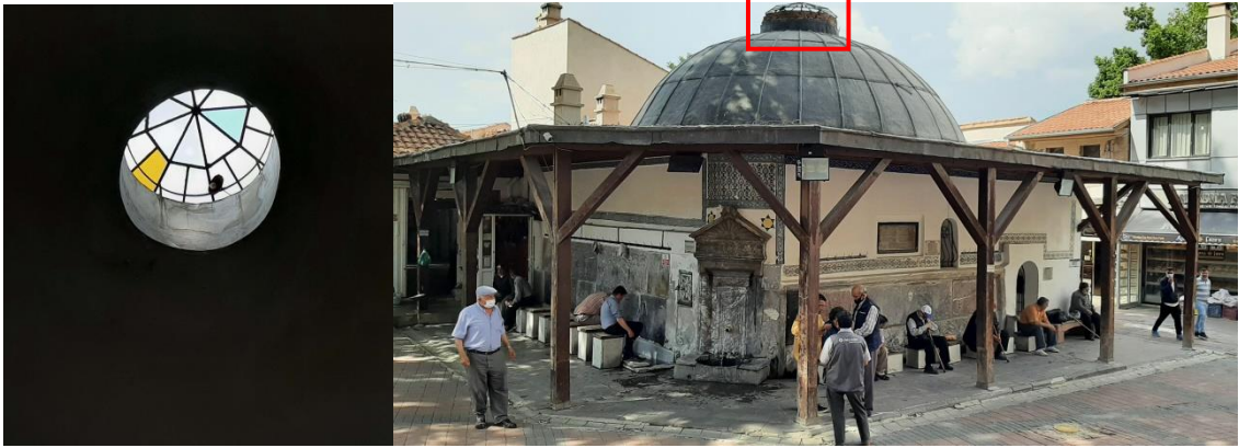
Resim 5.36. Solda sakahanenin kubbe açıklığının iç mekândan görünüşü, sağda kubbe açıklığı ve tuğla yükseltmenin dış mekândan görünüşü
