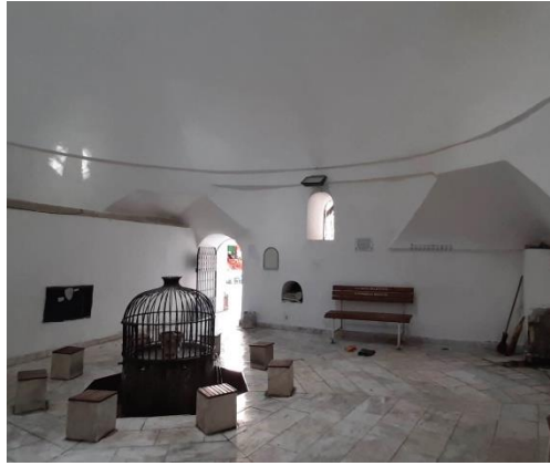
Resim 5.37. Havalandırma ve aydınlatmaya katkı sağlayan mazgal pencere ve giriş kapısı
