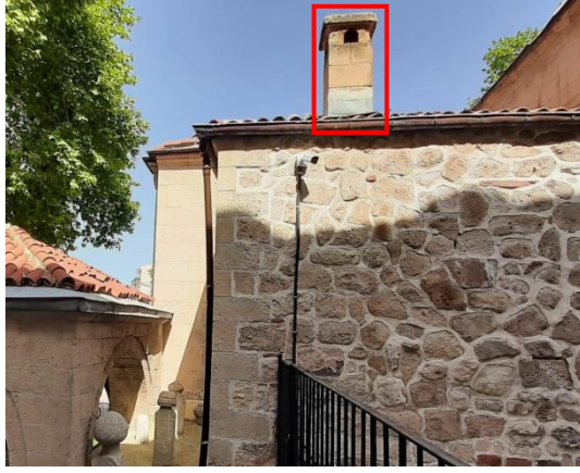
Resim 5.22. Havalandırmaya katkı sağlayan baca ve şapkasının biçimi
