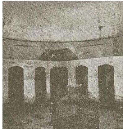
Resim 5.34. Solda sakahanenin şadırvanında temiz suyun aktığı fıskiye ve lüleleler, atık su tahliye gideri ve sağda sakahanenin cephesindeki mermer çeşmeler ve köşe çeşmesi
