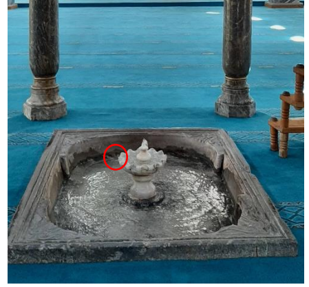
Resim 5.7. Mermer havuz ve ince tahliye kanalları
