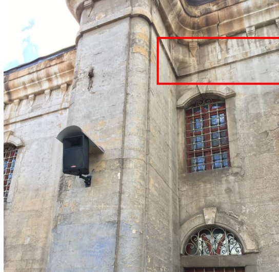
Resim 5.12. Tüm yüzeyler boyunca devam eden korniş ve furuşlar altındaki düz silme
