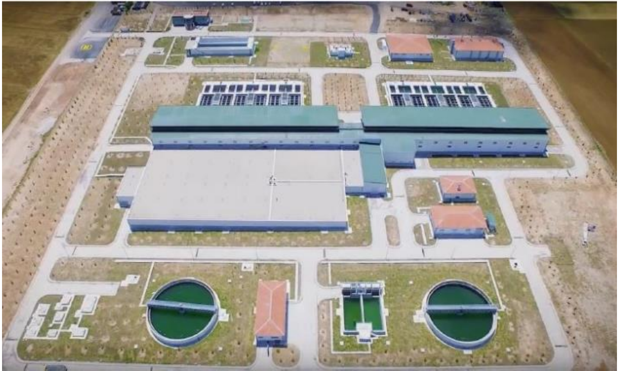
řekil 3.5. Seme İme Suyu Arıtma Tesisi (KOSKİ, 2024)
