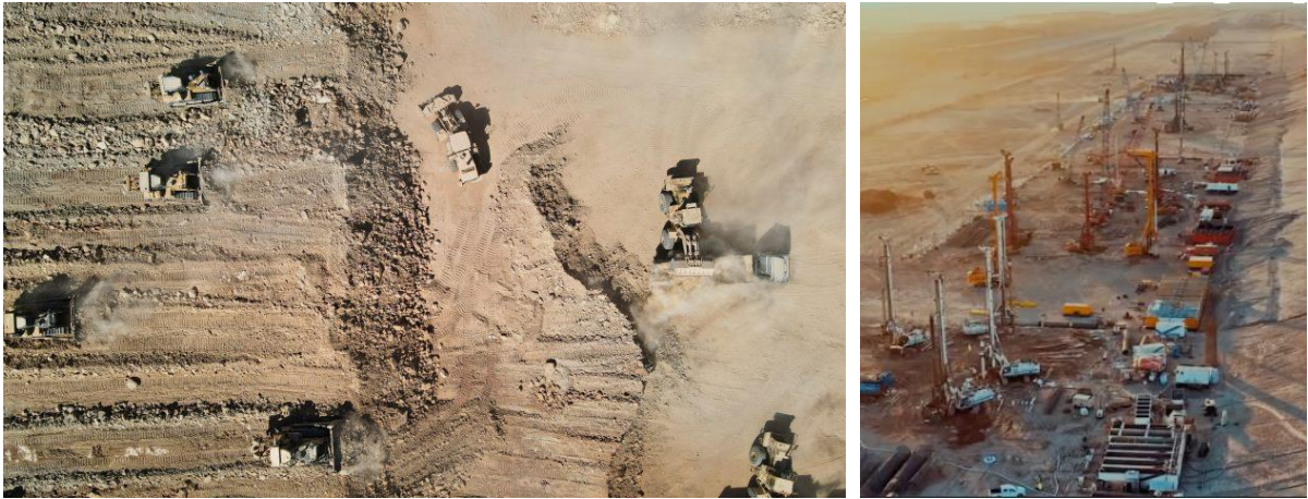
Şekil 4.8. The Line'in yapım aşamasından görseller (Arkitera, 2024a; NEOM, 2024)
