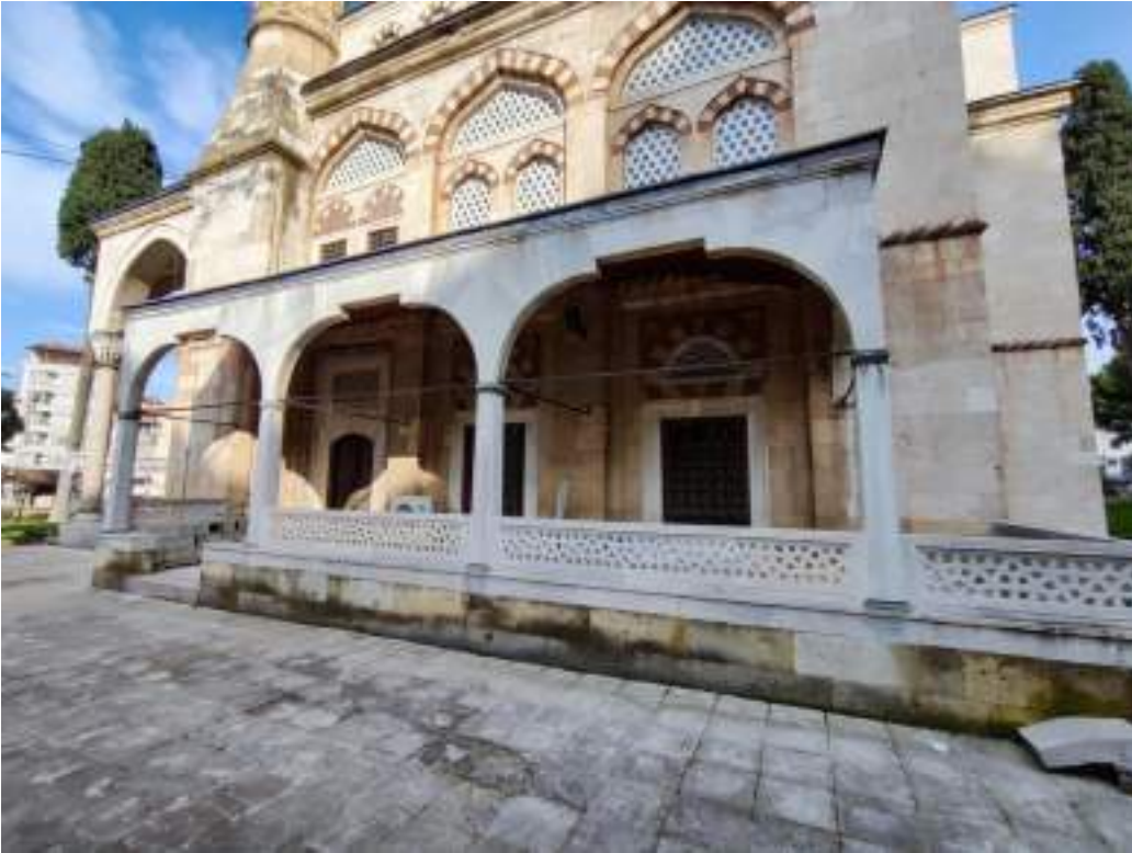
Resim 25- Batı cephesi revakları
