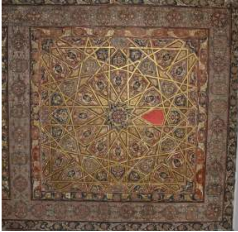
Resim 121- Hünkâr mahfili altındaki ahşap kalemişlerinin doğu dilimi
