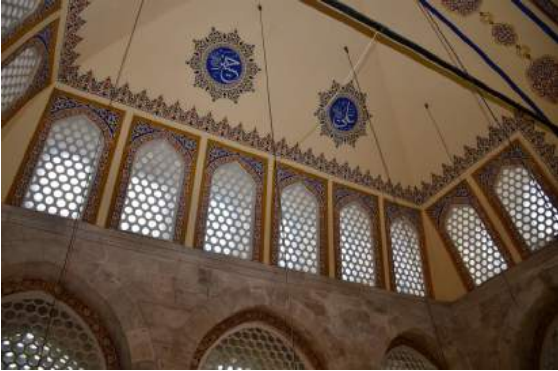
Resim 175- Doğu duvarı yüzeyindeki alçı içlikler
