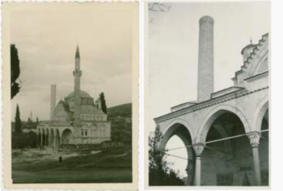
Resim 5 Yeniden yapılmak üzere minarelerin sökülmesi (E. Akbalık)
