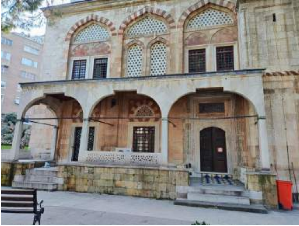
Resim 24- Doğu cephesi revakları
