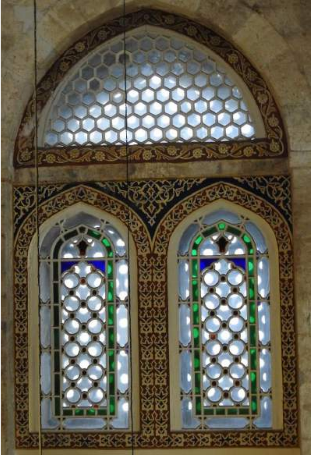
Resim 70- Revzenli camların etrafındaki tezyînâtın detayı
