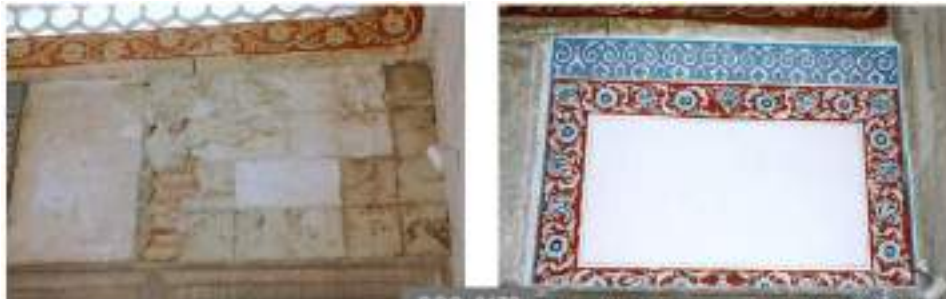
Resim 133-Hünkâr mahfilinden çalınan batı penceresinin alınlığı, ve kalemîsi ile yeniden tezyin edilmiş hali (S.Gök)
