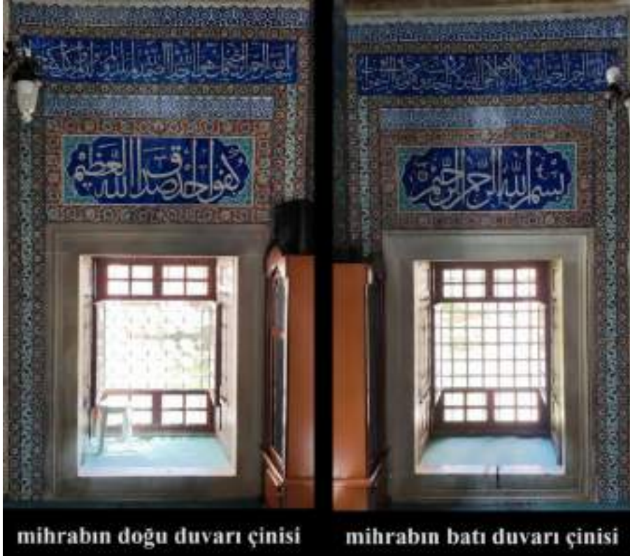
Resim 140- Mihrap bölümü doğu ve batı duvarı çini tezyînatı
