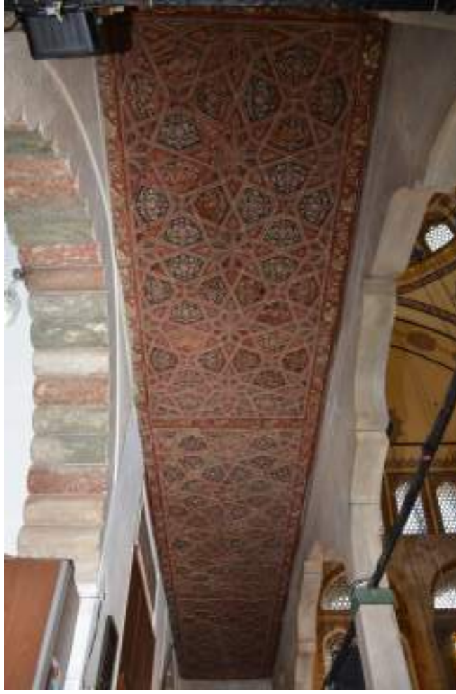
Resim 100- Kadınlar mahfili altındaki ahşap kalemşelerinin bütünsel görünümü
