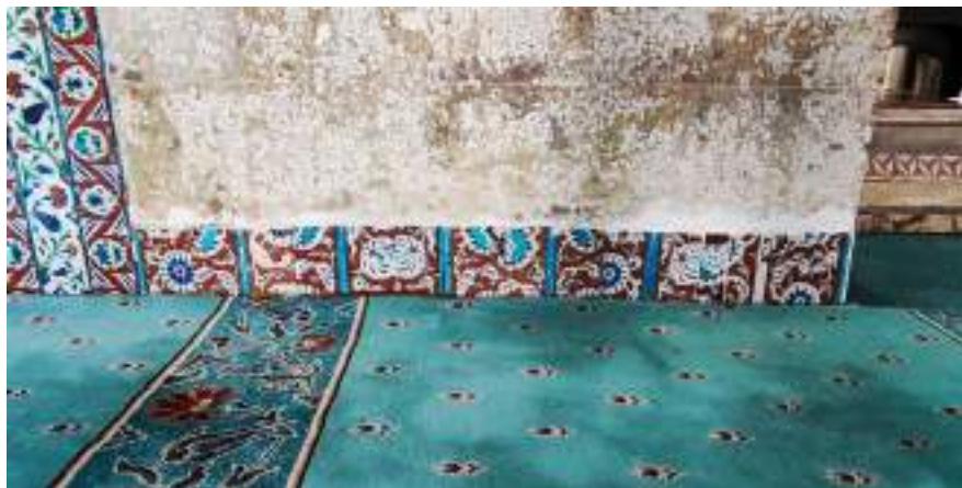
Resim 136- Mihrap bölümünün batı duvarındaki süpürgelik genel görünümü
