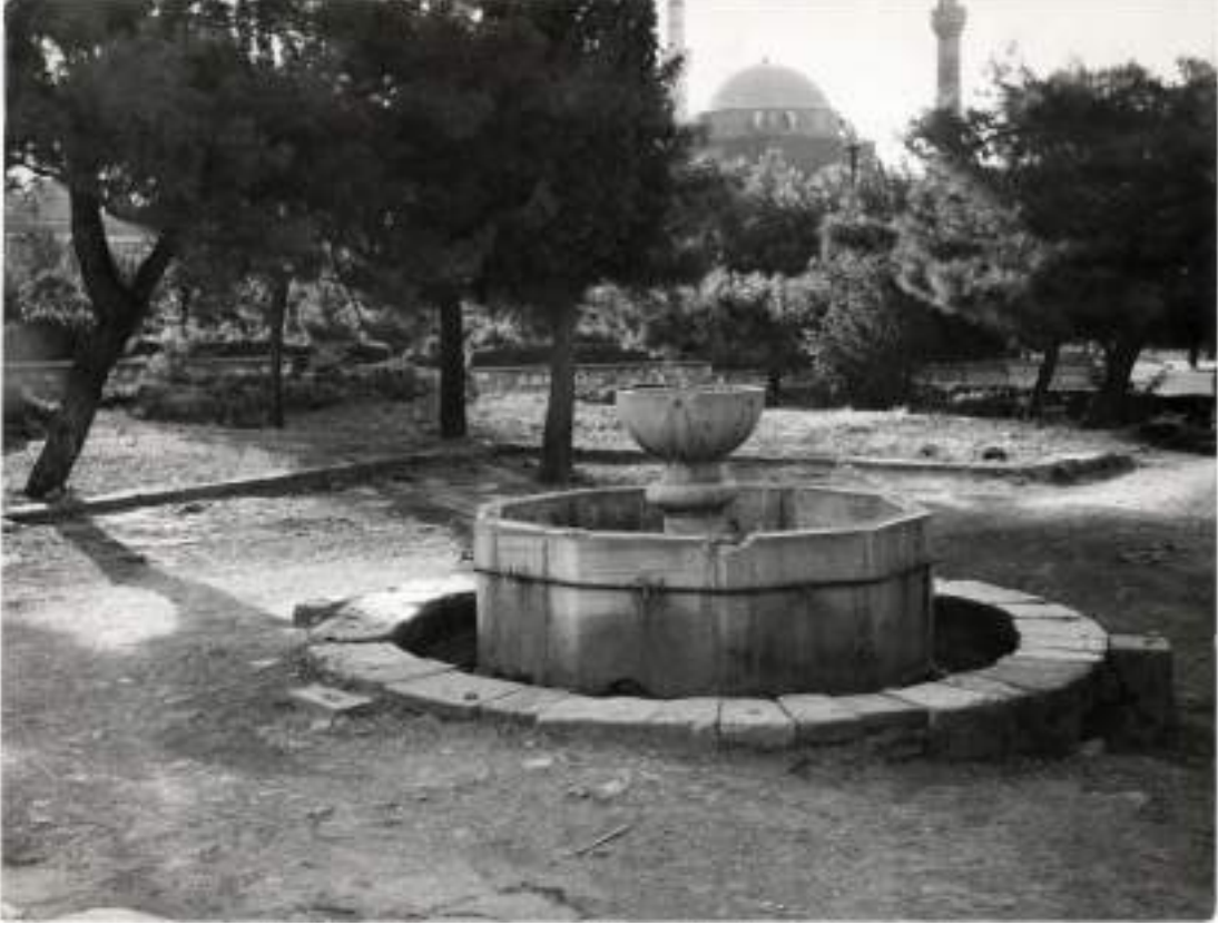
Resim 12- Medrese odaları yıkıldıktan sonra ortada kalan şadırvan (E.Akbalık)
