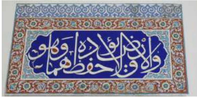
Resim 158- Çalınan pano yerine yapılan 9 no'lu pencere alınlığı kalemîsi (batı)
