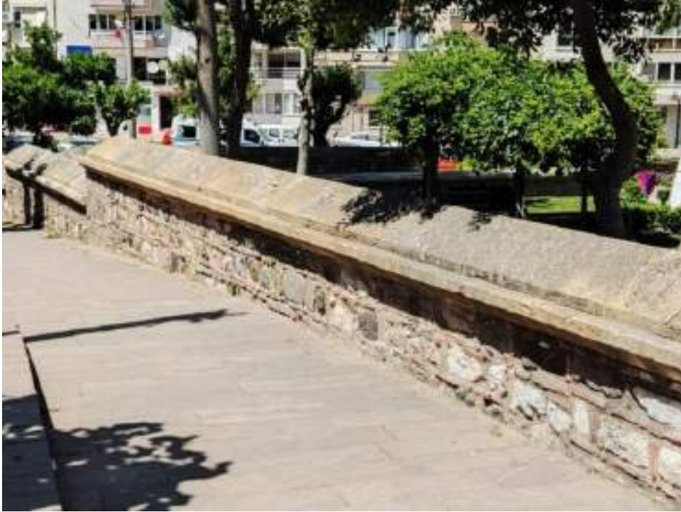
Resim 15-. Avluyu çeviren alçak, kesme taştan yapılmış duvar (2024)
