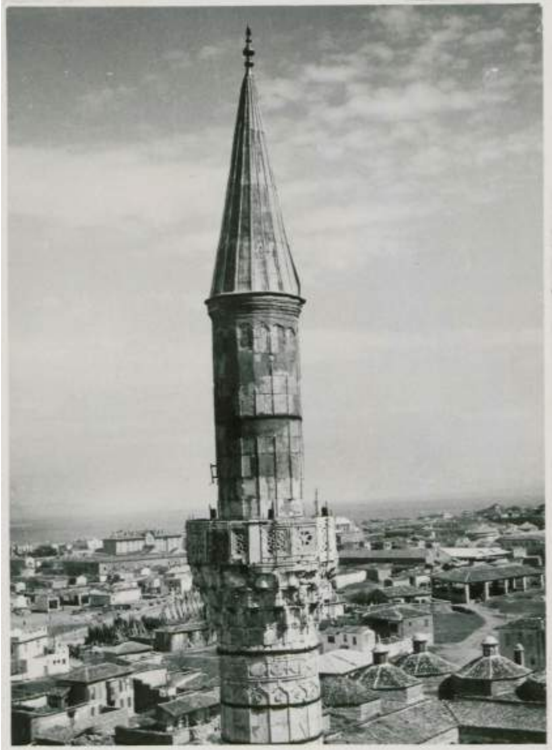
Resim 1- Zarar gören minareyi sağlamlaştırmak için takılan demir çemberler (E. Akbalık)
