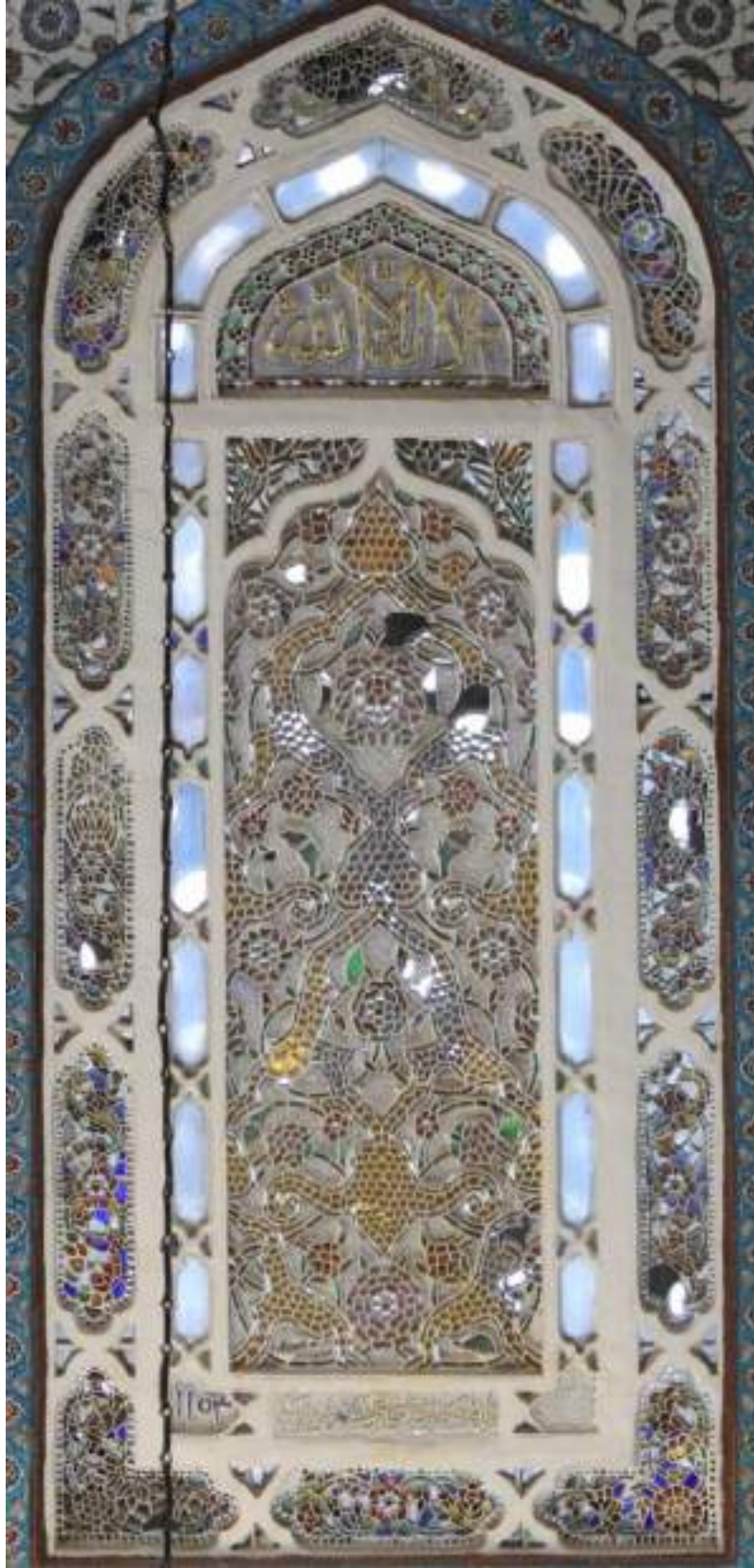
Resim 170 Mihrabın güney duvarının batı yanındaki revzen
