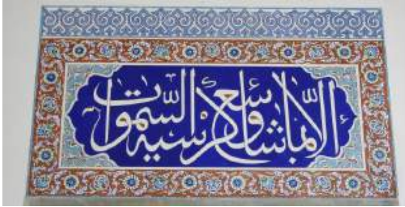
Resim 157- Çalınan pano yerine yapılan 8 no'lu pencere alınlığı kalemîsi (batı)
