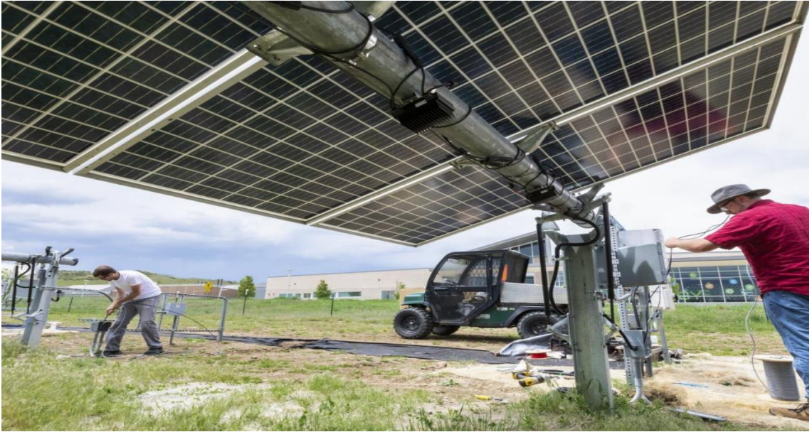
Şekil 3.26 Çift yüzeyli güneş paneli ( https://www.indyturk.com/node/649181/ya%C5%9Fam/elektrik-%C3%BCretimini-muazzam-derecede-art%C4%B1ran-%C3%A7ift-tarafli%C4%B1-g%C3%BCne%C5%9F-paneli-icat-edildi )
