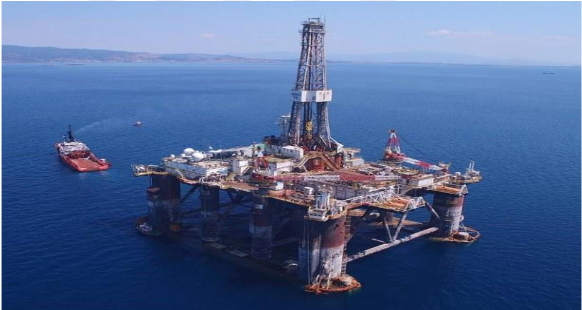
Şekil 3.4 Doğalgaz enerji santrali ( https://www.tr724.com/reuterskaradenizde-tuna-1-kuyusunda-800-milyar-metrekup-dogalgaz-bulundu/ )
