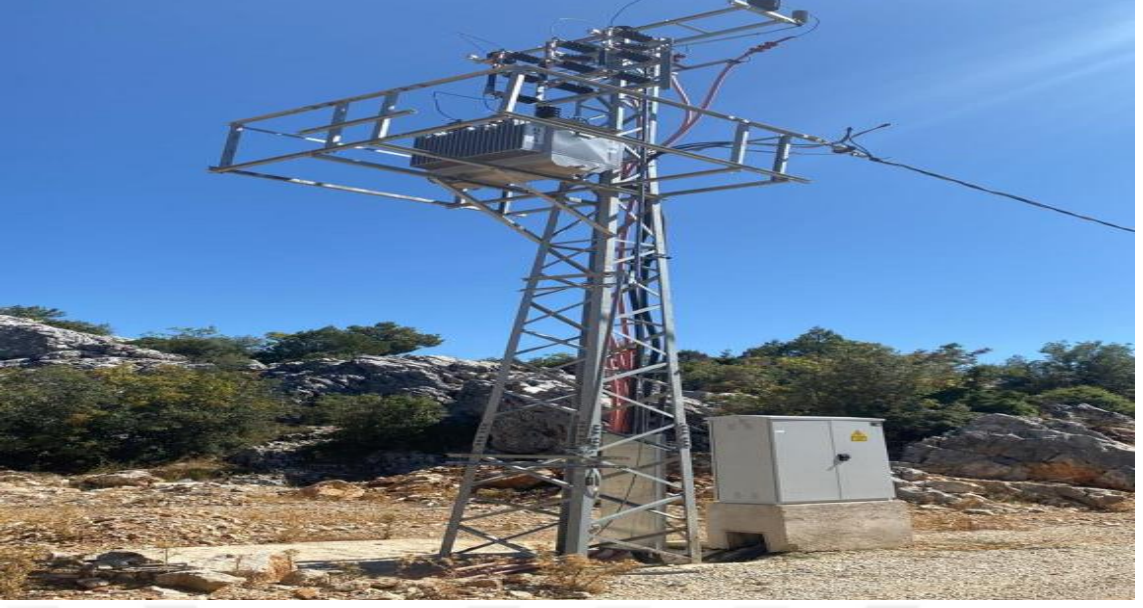
Şekil 3.22 Direk tipi trafo
