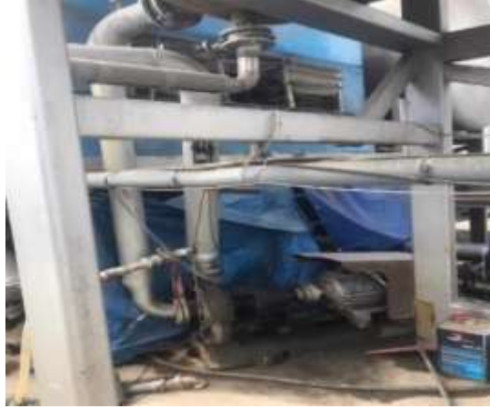
Şekil 4.11. 800 tonluk kule pompası
