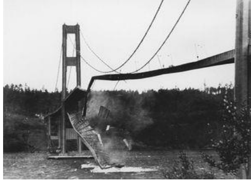
Şekil 12. Tacoma Narrows Köprüsü'nün çöküşü, Washington eyaleti, 1940 (Britannica)
